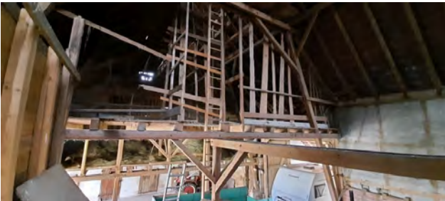
Abb. 15: Innenansicht von Gebäude 1
