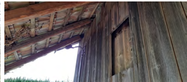
Abb. 22: Blick unter den Dachvorsprung von Gebäude 3
