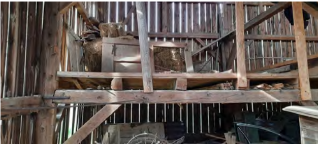
Abb. 27: An den Wänden von Gebäude 4 abgestellte Materialien
