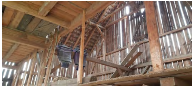
Abb. 26: Blick auf die Wandkonstruktion von Gebäude 4, welche offen und lichtdurchlässig ist.
