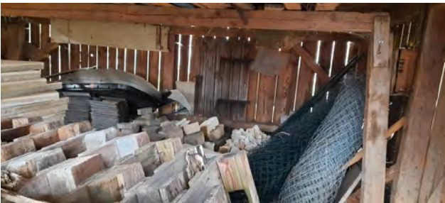
Abb. 25: Innenansicht von Gebäude 4, welches zum Lagern von Baumaterial genutzt wird.
