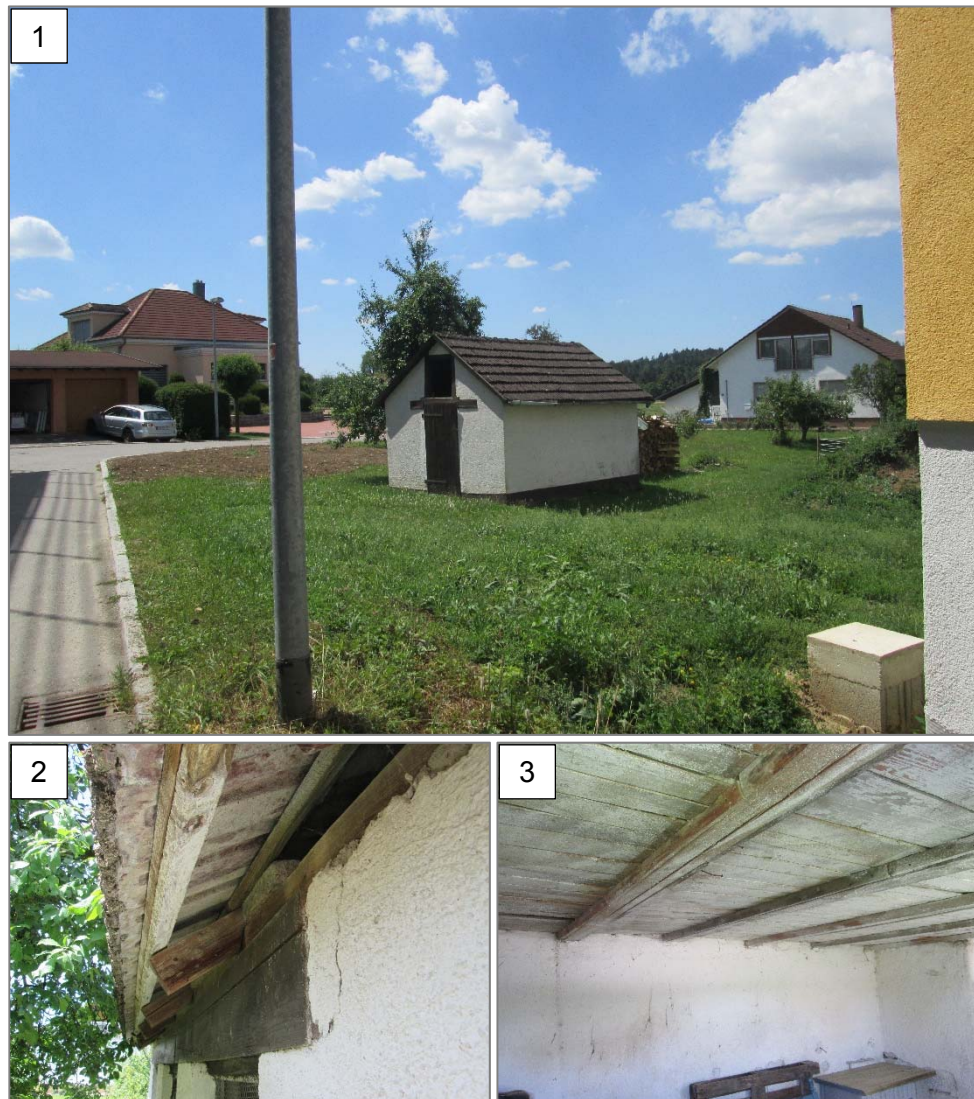
Abbildung 15: Schuppen auf Flst. Nr. 198/1, ohne aktuelle Besatzspuren 1: Übersicht, 2: Dachüberstand, 3: EG-Innenraum (Fotos: HPC AG, 09.07.2018)
