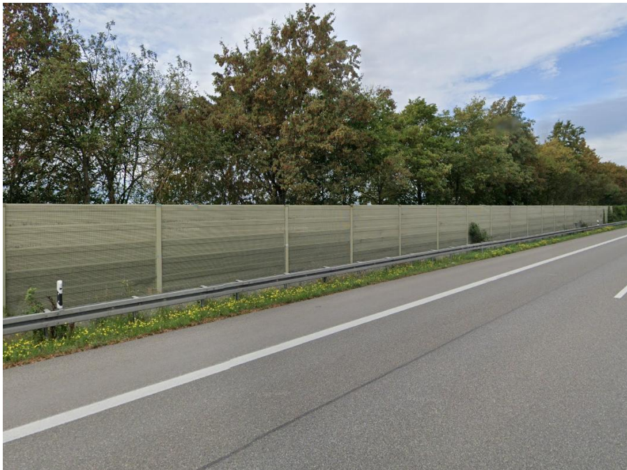
Abbildung 18: Bestehende Lärmschutzwand westlich der A 81 Ortschaft Rohrdorf
