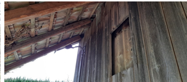
Abb. 22: Blick unter den Dachvorsprung von Gebäude 3
