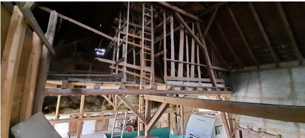
Abb. 15: Innenansicht von Gebäude 1
