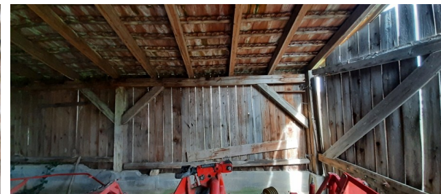
Abb. 24: Innenansicht der Wände und Decken von Gebäude 3.
