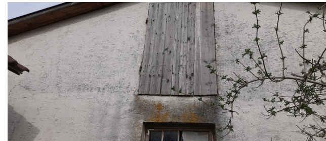
Abb. 20: Giebelseite von Gebäude 2
