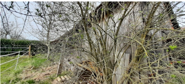
Abb. 21: Außenansicht von Gebäude 3
