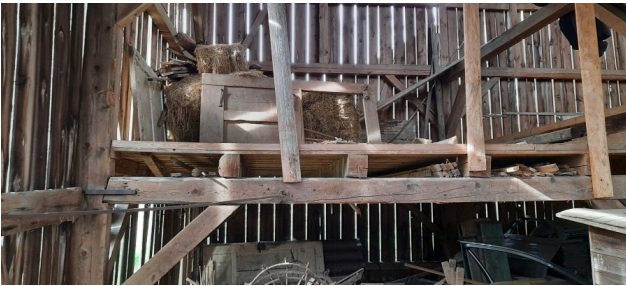
Abb. 27: An den Wänden von Gebäude 4 abgestellte Materialien
